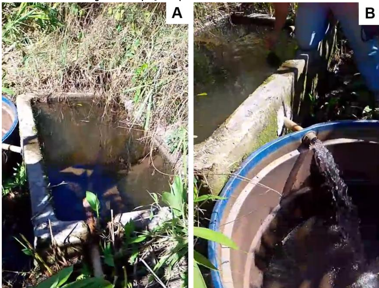
Figura 55 – Captação Superficial – Divisa com Carandaí
