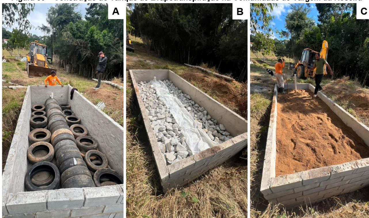
Figura 80 – Construção do Tanque de Evapotranspiração na Comunidade de Vargem da Roseira
