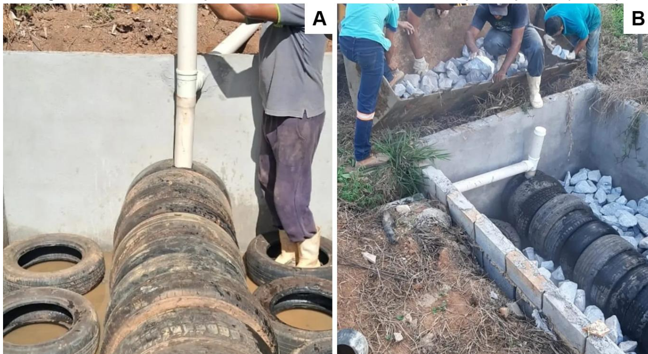
Figura 101 – Utilização de pneus na construção de Tanques de Evapotranspiração (TEVAP)
