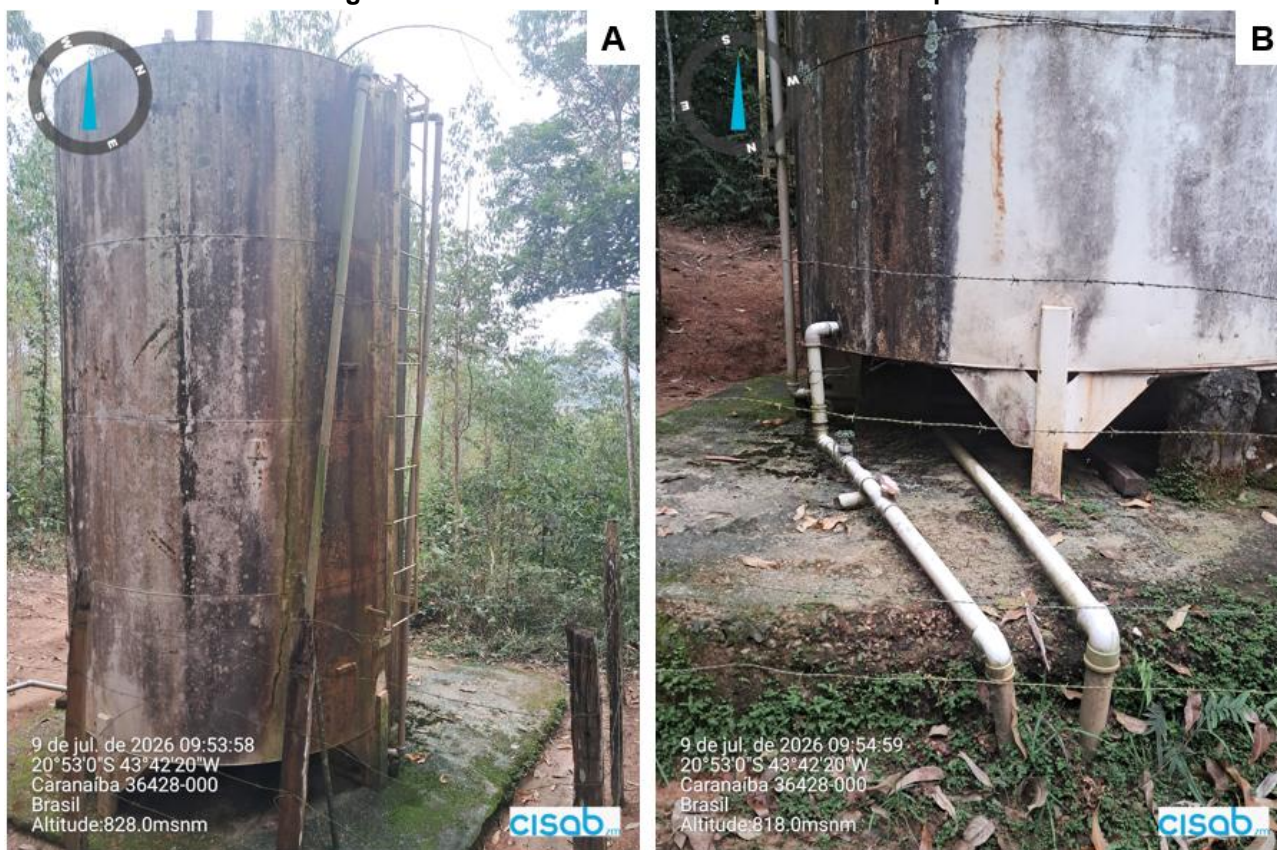
Figura 44 – Reservatório Bernardo Corrêa Principal
