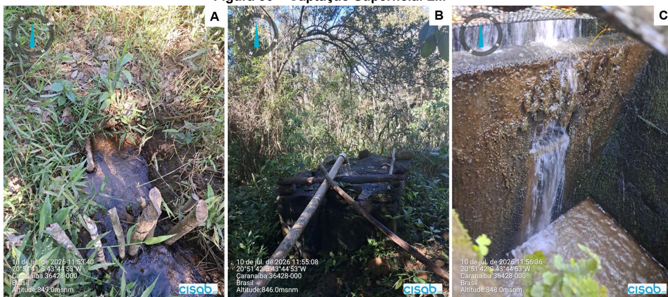
Figura 30 – Captação Superficial Lili
