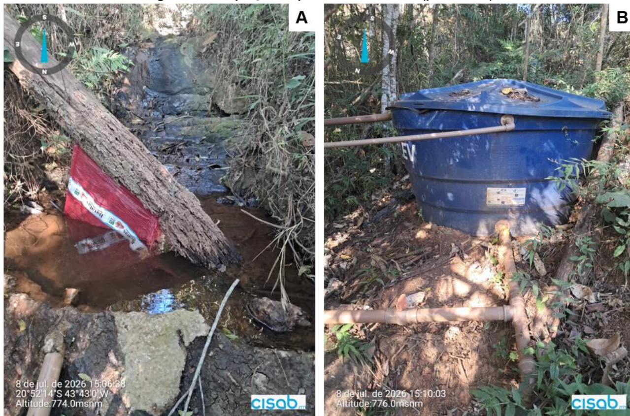
Figura 61 – Captação Superficial Fernandes (provisória)
