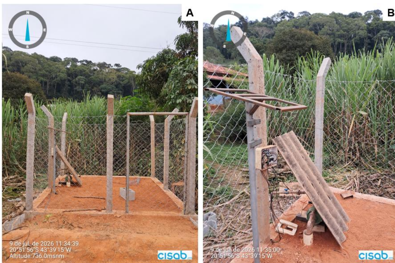
Fonte: CISAB ZM, 2026. Notas: A – Vista geral da captação; B – Detalhe das estruturas.
