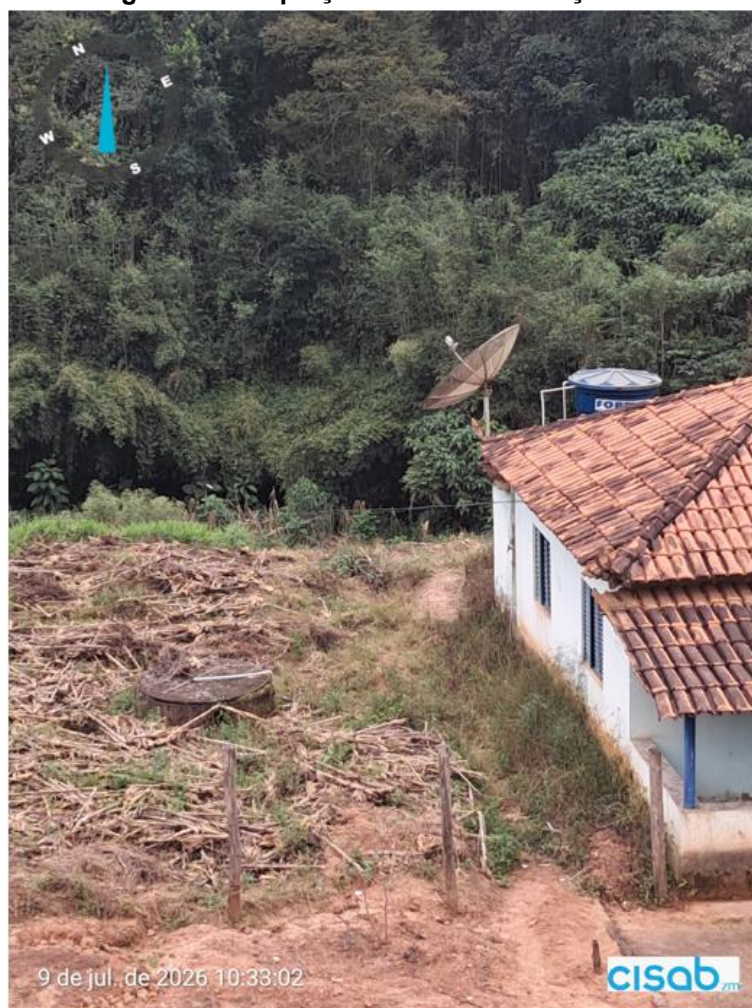
Figura 73 – Captação Subterrânea Poço Raso
