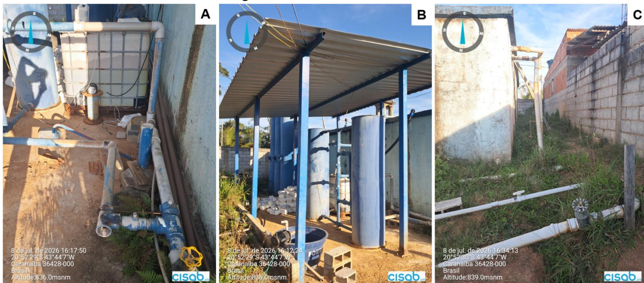
Figura 35 – Estruturas da ETA
