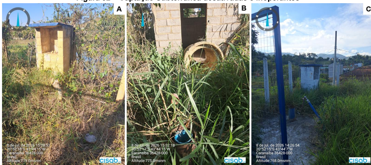
Figura 32 – Captação Subterrânea desativadas e inoperantes
