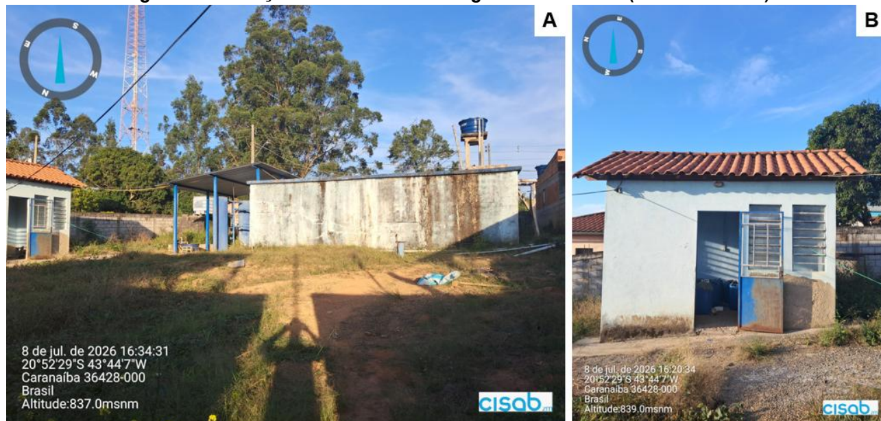
Figura 34 – Estação de Tratamento de Água de Caranaíba (ETA Caranaíba)
