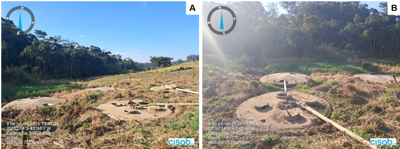
Figura 75 – Identificação da Estação de Tratamento de Esgoto (ETE) de Caranaíba
